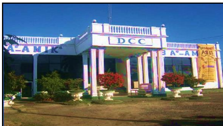
Gambar 4. Gedung Kampus ABA-AMIK DCC Pertama
